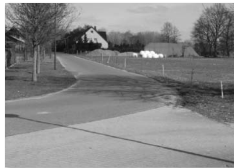
Sandweg von Trafostation bis Nr. 27 (links) und 2001 asphaltierte Straße (rechts)
