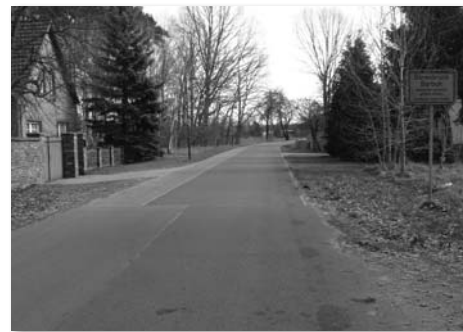
Straßenbau vom Ortseingang, von der KW-Straße bis Hanschkens Kurve, Bauphase (links) und 2017 (rechts)
